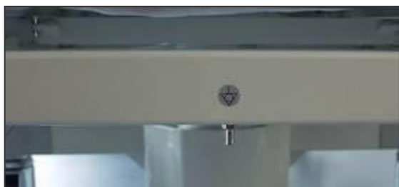
Fig. 1 Connettore equipotenziale – maschio
